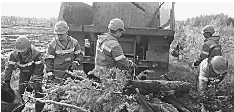
Нефтяники проводят рекультивацию земель на месторождении.
